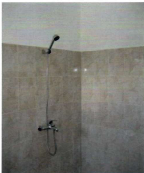
Фиг. 13. Ремонтиран санитарен възел
