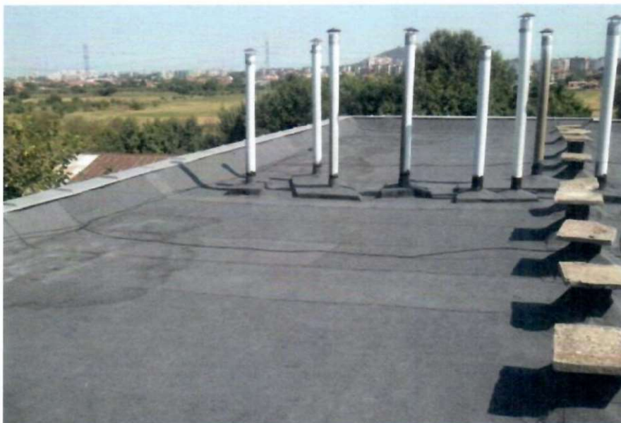
Фиг. 14. Ремонтиран покрив
